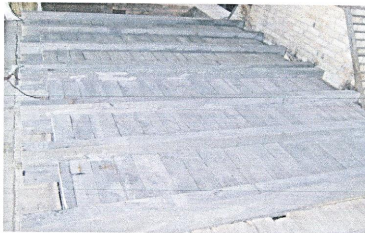
Рисунок 4. Вид образца деревянного перекрытия установленного на огневую печь со стороны обратной огневому воздействию
